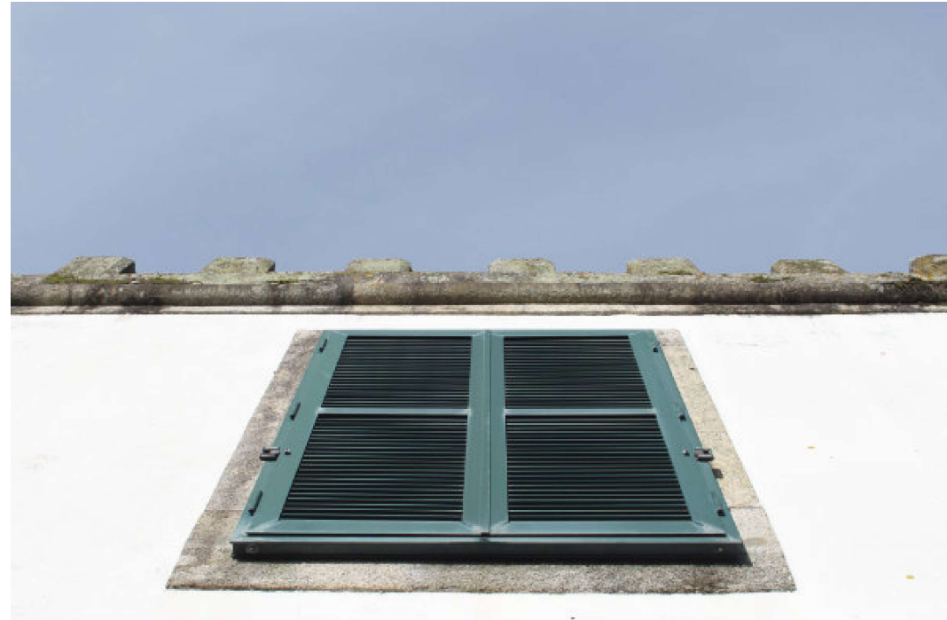
FOTOGRAFIA PORMENOR DA FACHADA PRÉ-EXISTENTE
